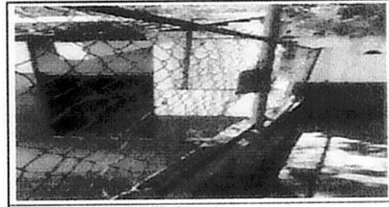
Foto: Demolición y Reparación de cuneta
